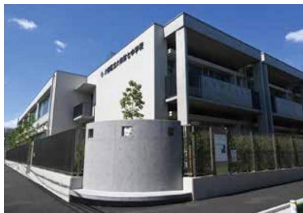
大森第七中学校 新校舎 (令和5年1月竣工)
