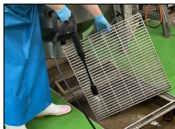
高圧洗浄機で 清掃をしている様子
