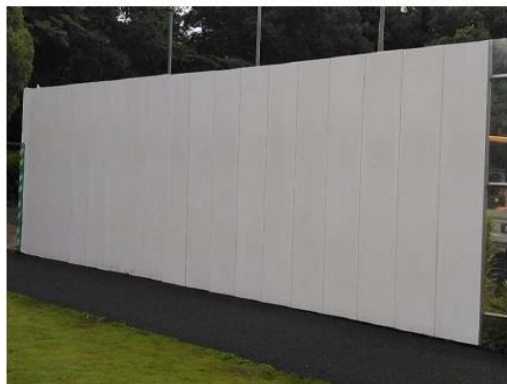
・仮囲い（フラットパネル 高さH=3m）
