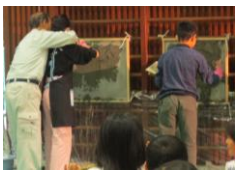
モルタルを 板に塗る体験
