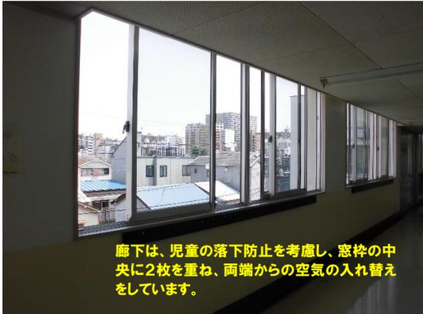
廊下は、児童の落下防止を考慮し、窓枠の中央に2枚を重ね、両端からの空気の入替えをしています。
