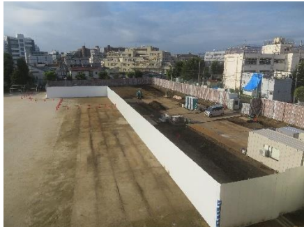
新校舎建設用地
