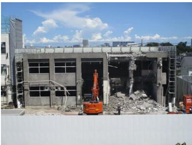
旧東校舎(旧専科棟)の解体工事が進んでいますが、いよいよ今日からは、躯体そのものの取り壊しが行われています。重機がバリバリと壁や床をこわしていきます。
