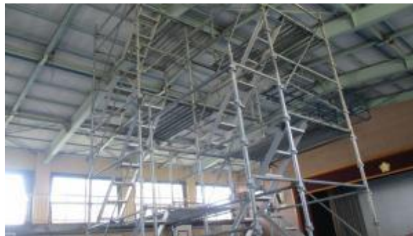
体育館内に高々と組まれた足場
