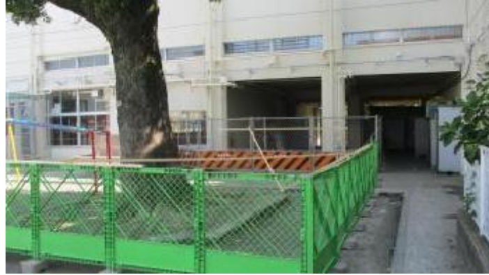
集会室・ピロティ付近には囲いがされています
