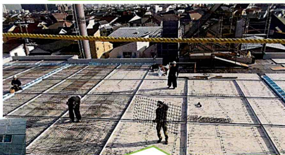
3階教室から見える屋上庭園の基礎を作っています。
