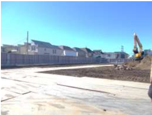
校庭の土を入れ替え、周りに走路を敷いています。1.8mの高さの支柱を3分割して立てていきます。
