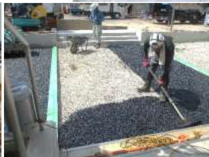
正門から玄関までの通路です。土を整え、アスファルトを敷いています。
