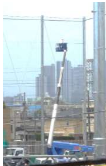
低い支柱に上部を合わせて1.8mの支柱に。ネットを掛けていく作業は高所作業車で技術者が行っています。
