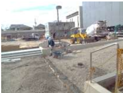
正門から玄関までの通路です。土を整え、アスファルトを敷いています。
