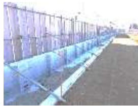
校庭の土を入れ替え、周りに走路を敷いています。1.8mの高さの支柱を3分割して立てていきます。
