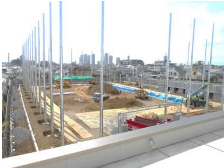
校庭の土を入れ替え、周りに走路を敷いています。1.8mの高さの支柱を3分割して立てていきます。
